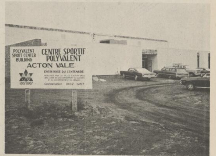
LE CENTRE SPORTIF, un projet qui avait été envisagé depuis quelques années à Acton Vale est maintenant une réalité. L'aménagement sera complété d'ici peu et l'inauguration officielle aura lieu dimanche prochain en présence de plusieurs dignitaires. (Photo: Gaston Champagne)
