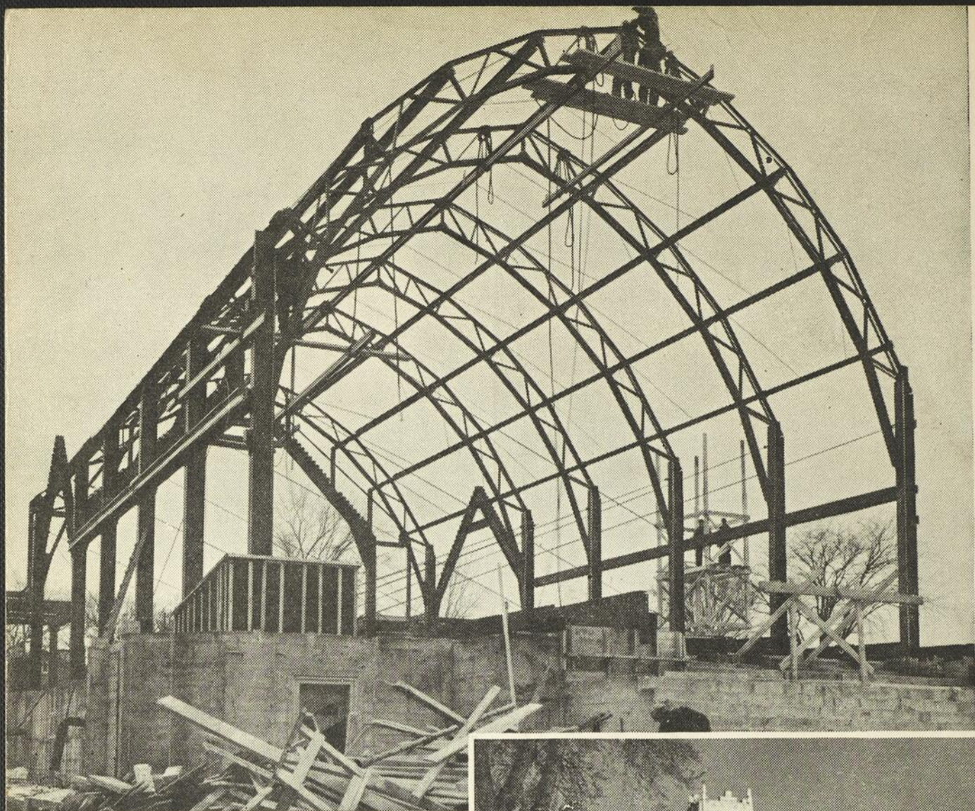
Vue de la charpente de l'Eglise de la Résurrection de Notre-Seigneur à Lachine.
