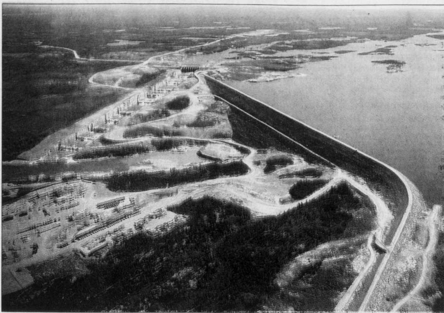
Le barrage LG2, érigé sur la rivière La Grande, à la Baie-James.
