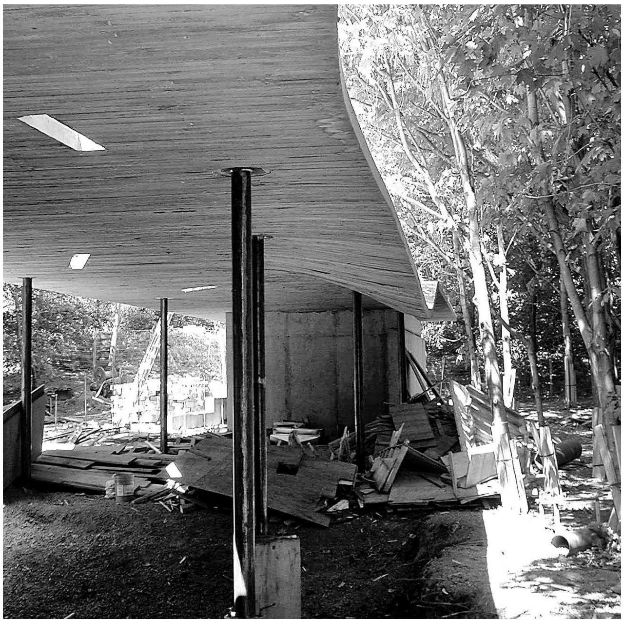
Le Jardin des Premières-Nations, maquette et chantier.
