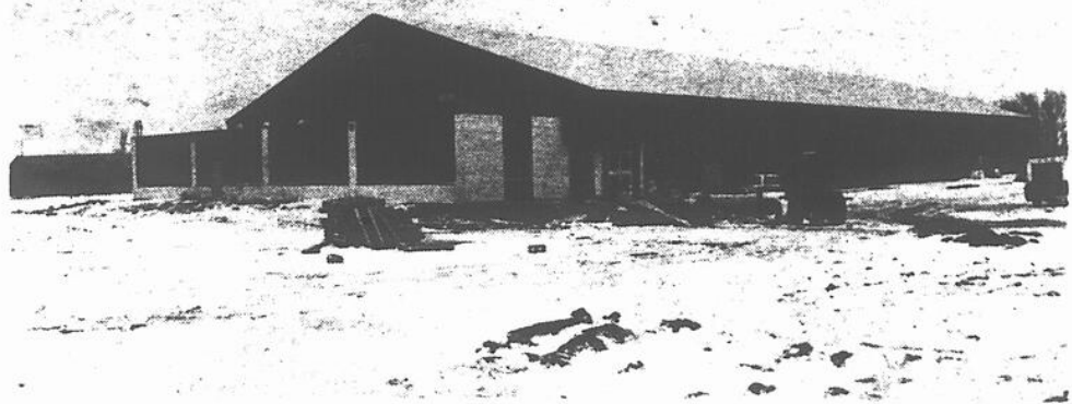
La charpente de l'édifice a été recouverte depuis quelques temps.
