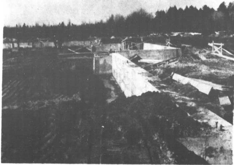
Fin avril... Déjà, on peut deviner la forme que prendra le contour extérieur de la future école car les fondations de béton ont été coulées. (PHOTO STUDIO LAFERRIERE ENRG. 832-3266)
