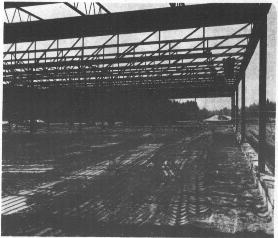
Les ouvriers de Bernard Malo Inc. ont su se passer du tiède soleil de mai pour faire pousser leurs poutres de métal qui, en peu de temps, finirent par s'agripper les unes aux autres pour former un solide treillis d'acier. (PHOTO STUDIO LAFERRIERE ENRG. 832-3266)
