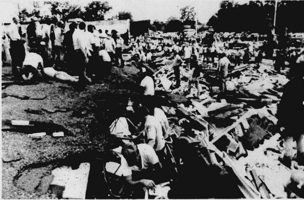
VIOLENTE AVERSE: Le toit du magasin n'a pas résisté à une violente averse et s'est effondré sur clients et employés qui ont eu la vie sauve.
