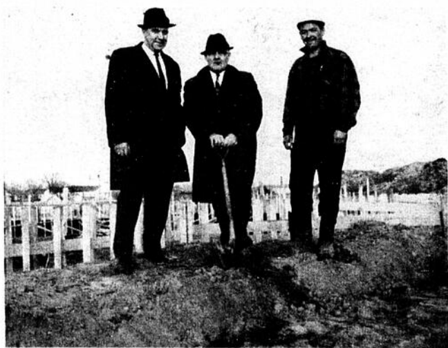
Lors de l'inauguration des travaux du Centre culturel de Farnham, on a pensé à prendre une photo montrant son Honneur le Maire Arthur Audette, levant la première pelletée de terre, accompagné dans ce geste par l'échevin Gérard Harbec, à gauche, et par M. Marcel Lehoux contremaître des travaux. Le tout doit être terminé pour la fin de mars ou le commencement d'avril 1967. (Photo: Marc Robitaille, Farnham.)
