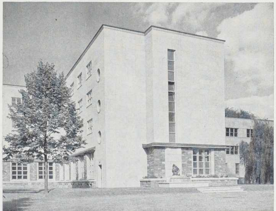
L'aile qui avance en saillie vers la rue et qui loge une partie des chambres des élèves. À gauche, détail du St-Thomas à l'avant de cette aile.
