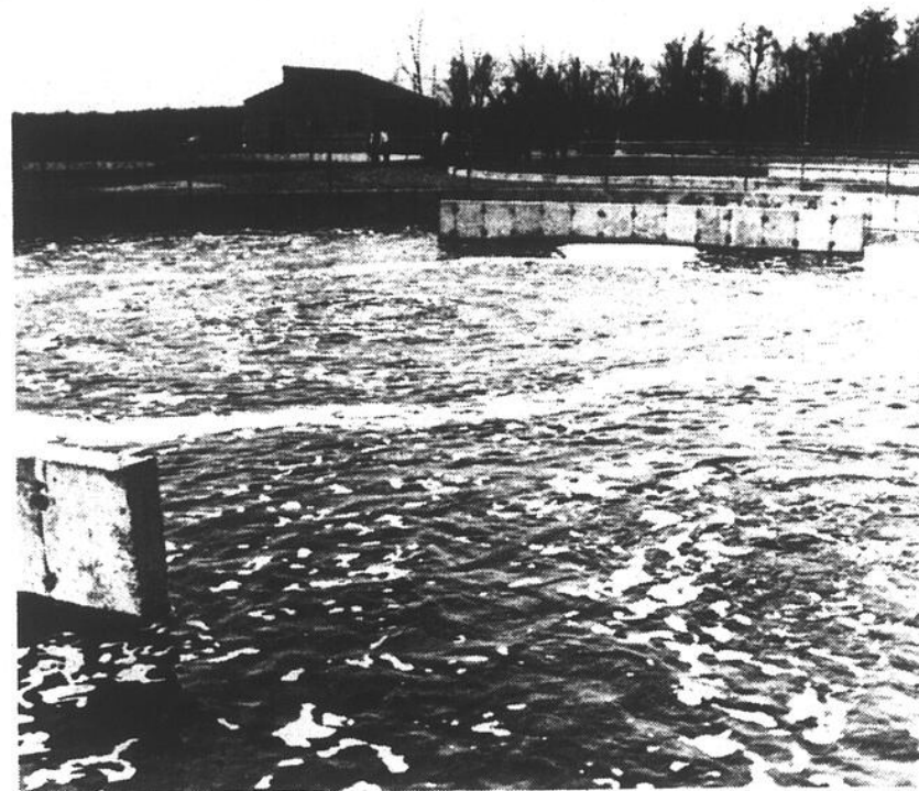
L'usine compte quatre bassins munis d'aérateurs. C'est la première fois au Québec qu'on applique le principe des étangs aérés à des citernes de béton. (Photos Jacques PAUL)
