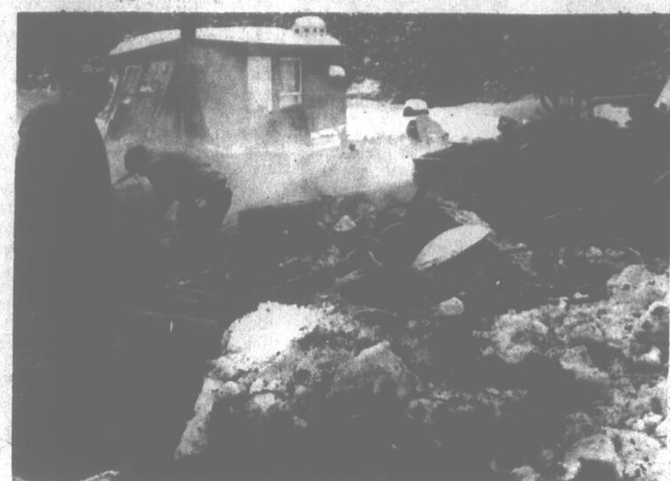
Voilà ce qui est resté de la maison qu'occupaient M. Gilles Cloutier, son épouse et son petit-fils sur le 9ème rang, près du Pavillon du détour, suite à l'incendie qui s'est déclaré aux environs de 5 heures 30, hier matin. Les trois occupants ont eu la vie sauve grâce à un détecteur de fumée qui les a avertis qu'un incendie était en cours. Après une brève visite à l'hôpital, M. Cloutier, que l'on peut apercevoir à l'avant-plan, est revenu sur les lieux pour constater les dégâts.
