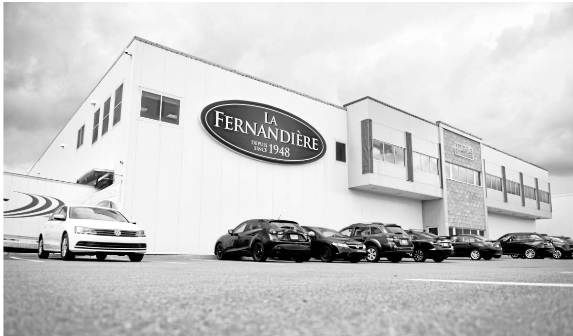
Après les travaux d'agrandissement, la manufacture La Fernandière passera d'une superficie de 24 000 pieds carrés à 45 000 pieds carrés. — PHOTO: FRANÇOIS GERVAIS
