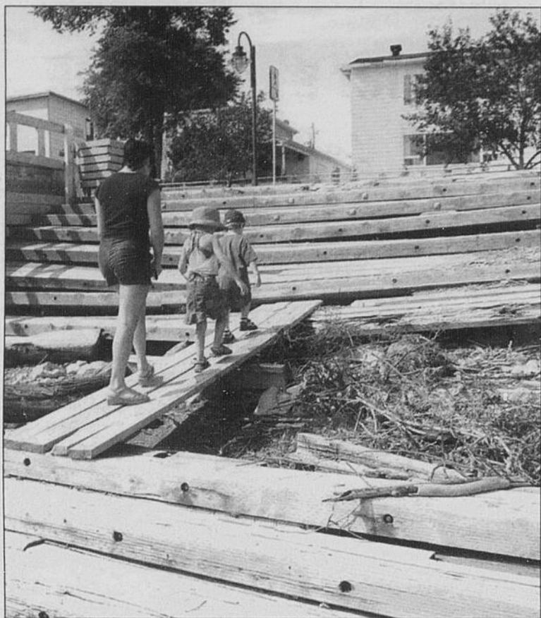
DANGER - L'escalier qui mène à la plage de la Baie des Ha! Ha! représente un danger pour les gens qui s'aventurent sur les berges.
