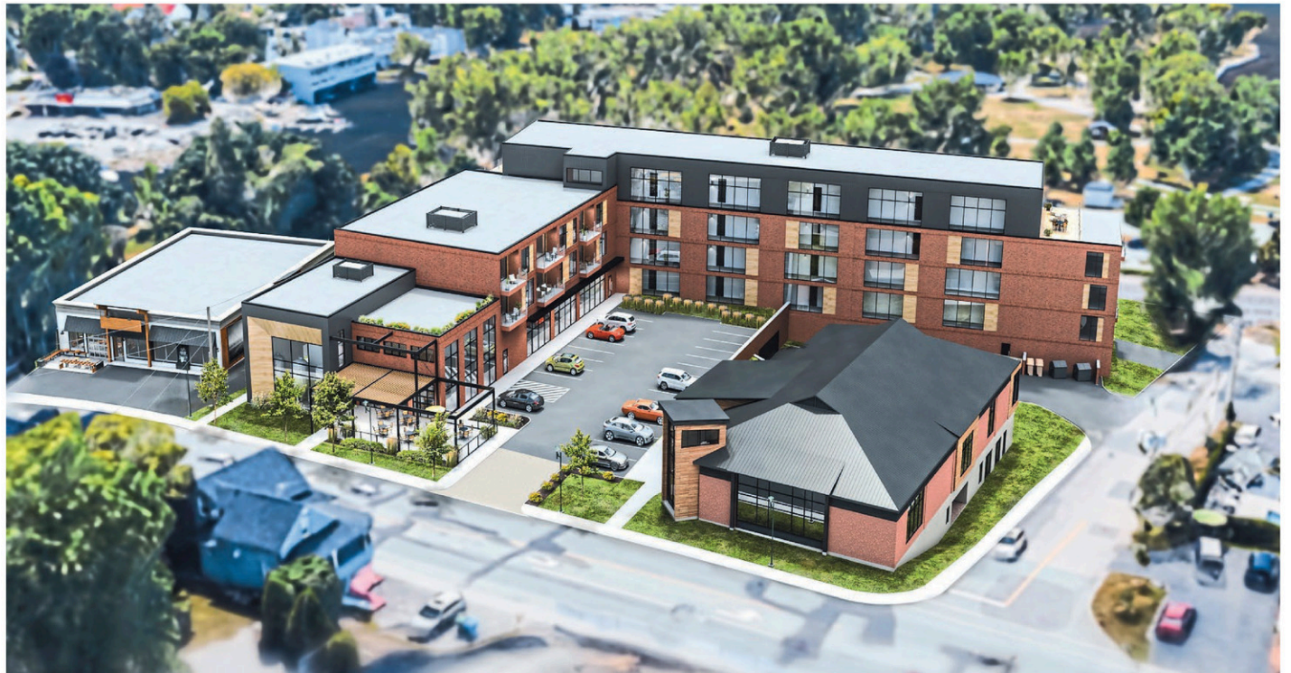
Les 43 unités du projet Ralph Espace Condos sont projetées à côté du 790, rue Principale Ouest. (Photo gracieuseté)
