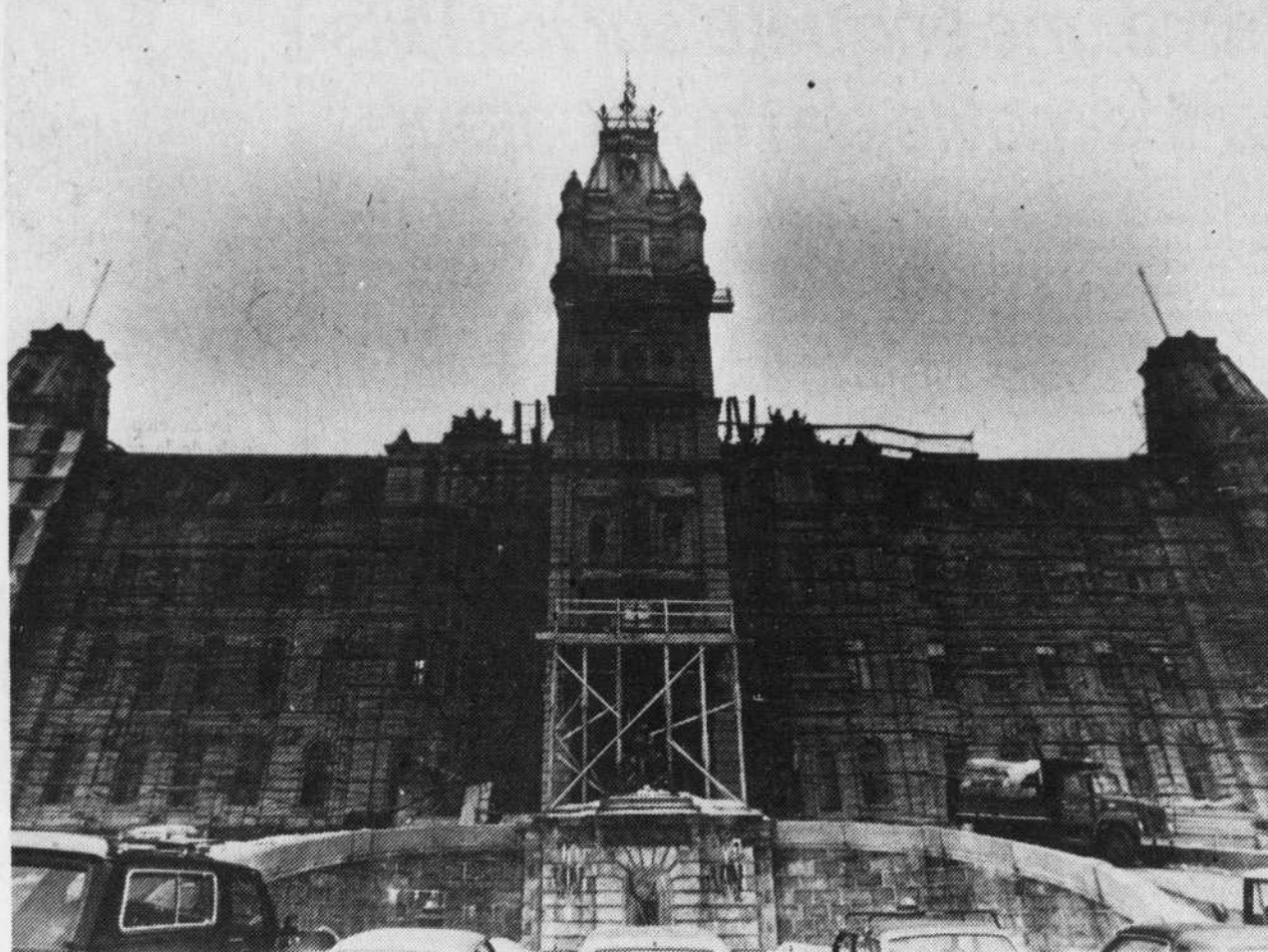
La façade principale du parlement, rue Dufferin, sera la première à sortir des chantiers. Les autres faces de l'édifice seront dégagées à l'automne. (Photo Paul Roux)
