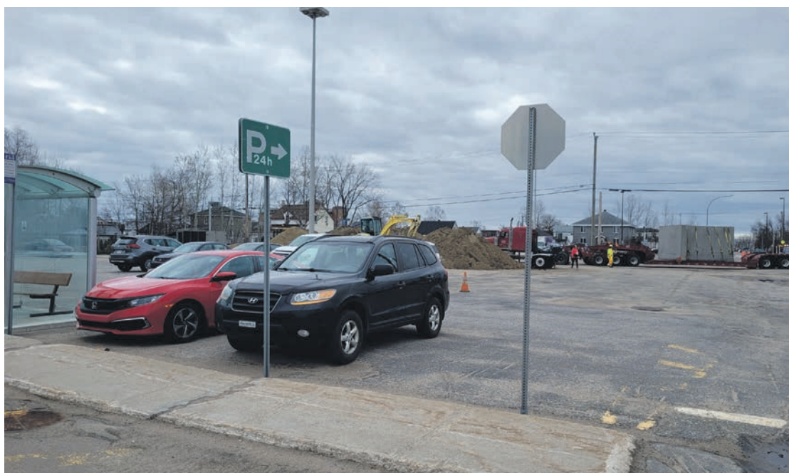
Le stationnement de la rue Jalbert est ciblé par un promoteur qui souhaite y construire un immeuble locatif pour répondre aux besoins criants du cégep de Baie-Comeau. On aperçoit derrière un dépôt de sable et de la machinerie en raison des travaux d'aménagement d'une place publique tout près. Photo Charlotte Paquet
