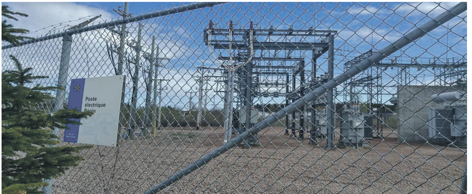
Hydro-Québec doit faire des travaux à ses installations pour que la Ville de Baie-Comeau procède à la modernisation du poste Bégin. Photo archives
