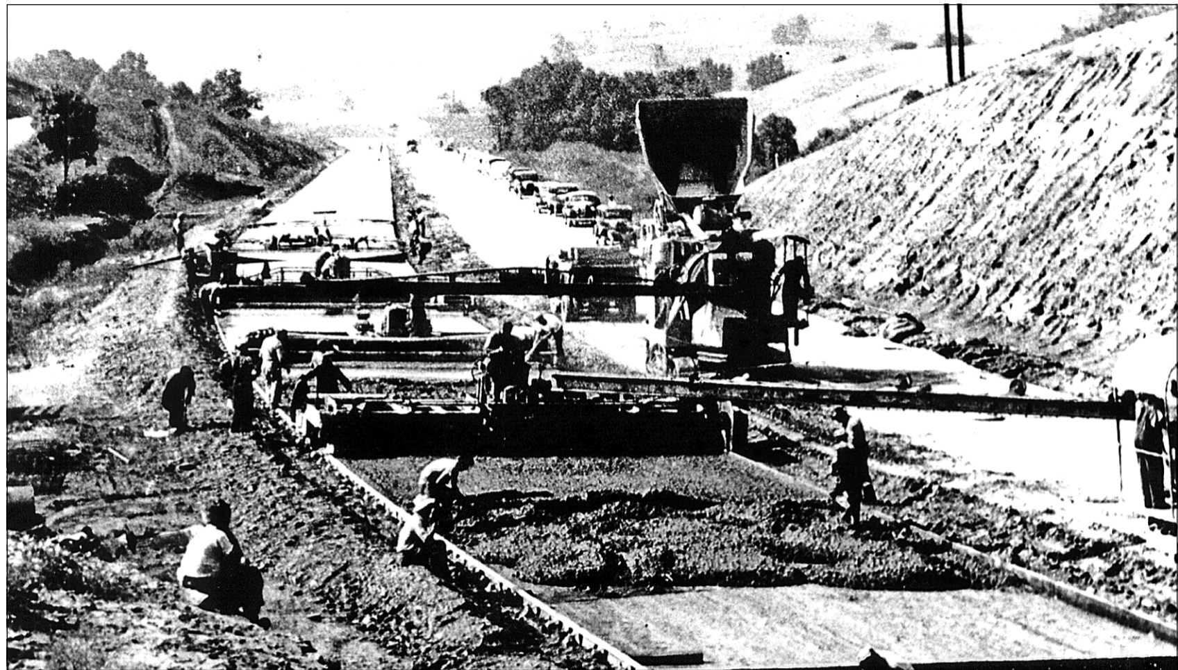
Construction du Pennsylvania Turnpike, précurseur du Interstate Highway System.
