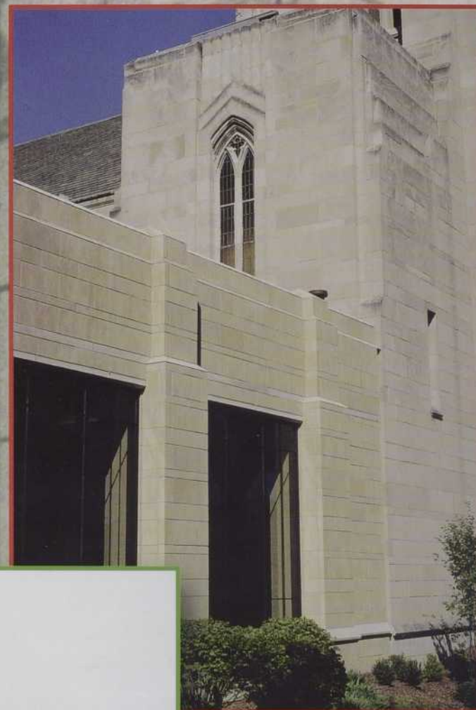
Église Grace Lutheran Jaeger Nickola Architects
