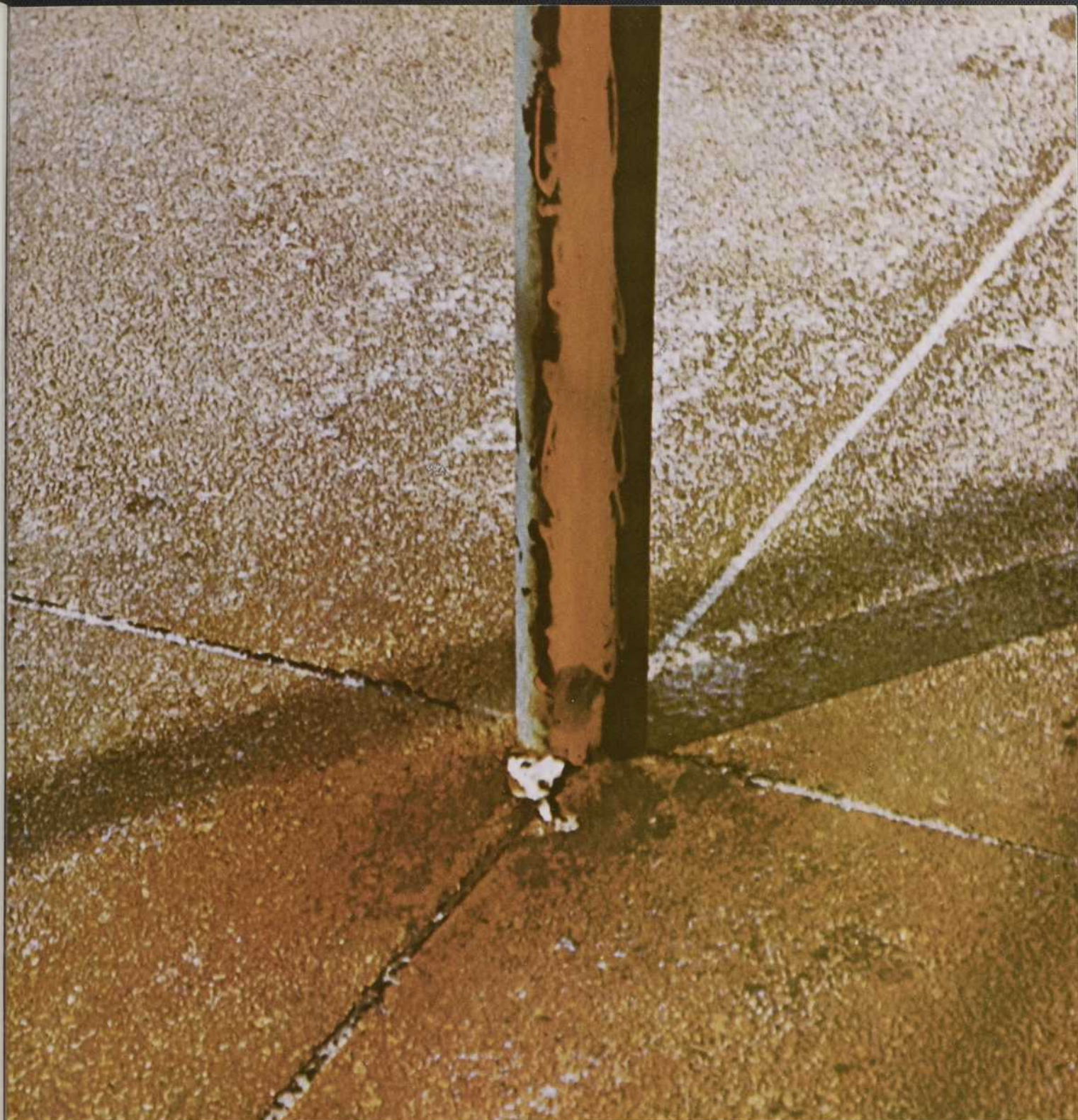
Cette colonne supporte la marquise d'un des plus nouveaux et des plus vastes centres commerciaux montréalais.
