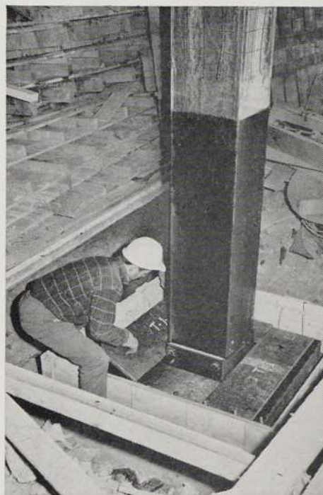
Installation des coussinets antivibration de plomb et amiante sur le sommet de l'assise de la colonne
