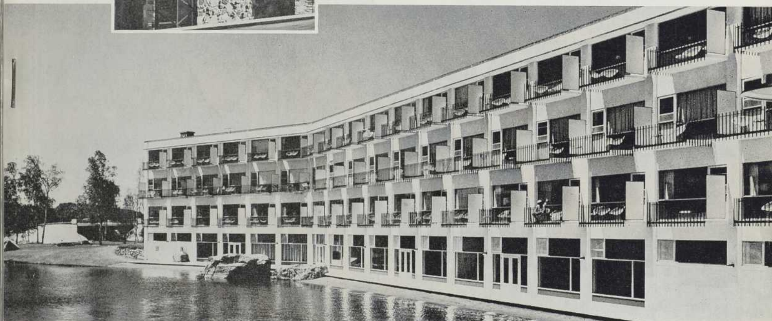
HOTEL L'ESTEREL, Ville d'Estérel, Qué.; Architecte : Jean-Guy Clément; Entrepreneurs : Simard & Frères Cie Ltée. Ascenseur Rotary Oildraulic vendu et installé par Alpin Elevator Co. Ltd., Montréal, Qué.
