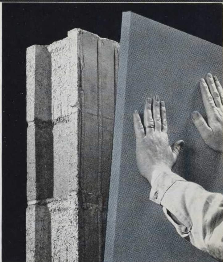
3. Pressez le panneau Styrofoam FR en place.
