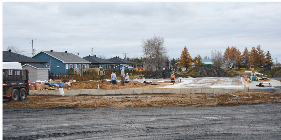
La Ville de Princeville a octroyé un permis pour une valeur de 600 000 $ pour la nouvelle construction commerciale qui accueillera, entre autres, la Rôtisserie Fusée. (Photo TC Media – Carol Isabel)
