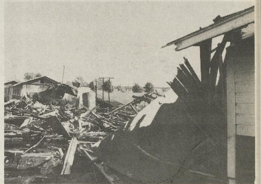
L'élément destructeur a ravagé cinq des onze unités de motel en plus d'avoir rasé une remise.
