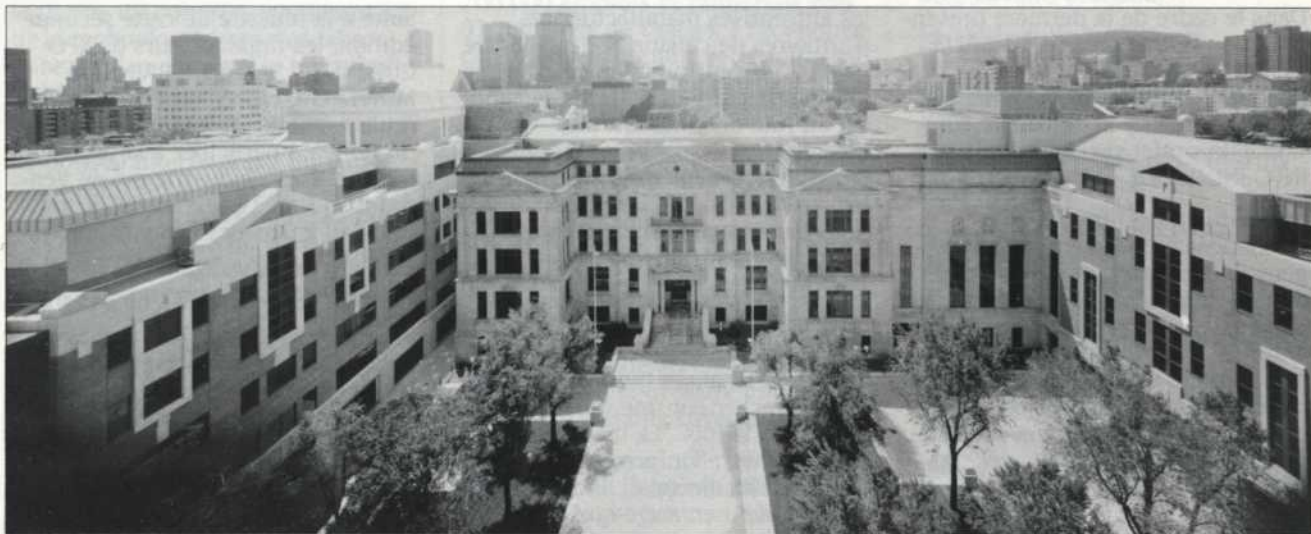
Trois nouveaux pavillons de l'UQAM. Au centre, devant la Place Pasteur: Le pavillon Athanase-David (entrée 1430, rue Saint-Denis). À gauche: Le pavillon des sciences de la gestion (entrée 315, rue Sainte-Catherine Est). À droite: Le pavillon de la musique (Entrée:1440, rue Saint-Denis)
