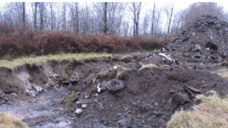
Excavation de déchets
