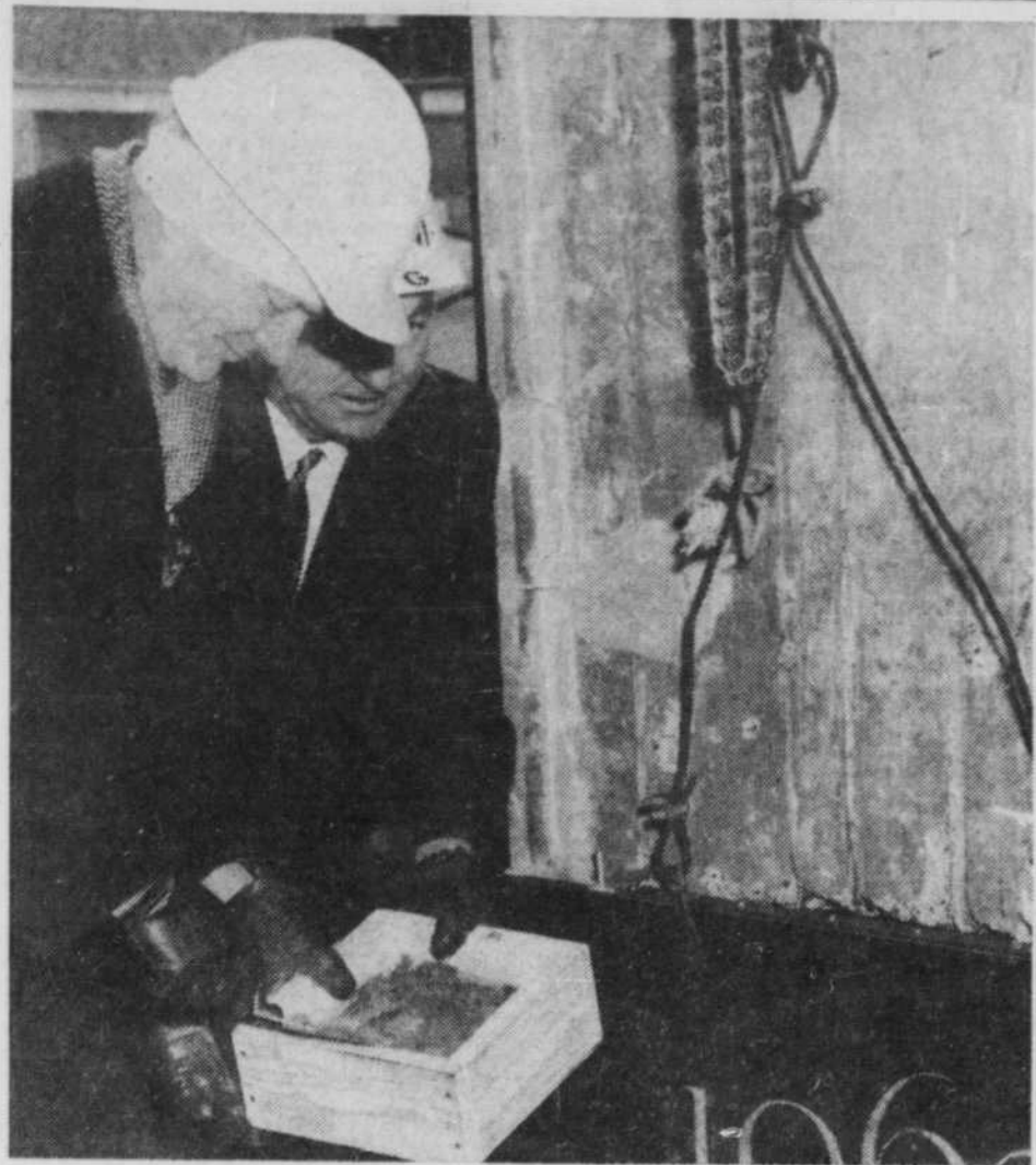
Hier avait lieu la pose de la pierre angulaire du nouvel immeuble de la Banque Canadienne Impériale de Commerce, à l'angle des rues Peel et Dorchester. On remarque sur la photo, M. Neil J. McKinnon, président de la banque et, à l'arrière-plan, M. Vern Gruenig, surveillant général du chantier de construction.
