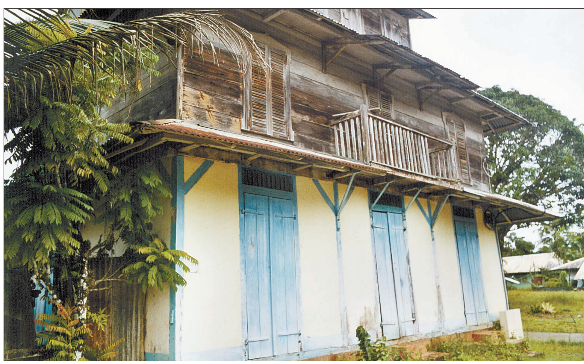
Une des formes d'architecture les plus représentatives de la Guyane française, la case créole en bois avec ses grands volets et ses petits toits de tôle dans le village de Régina, au sud de Cayenne.
