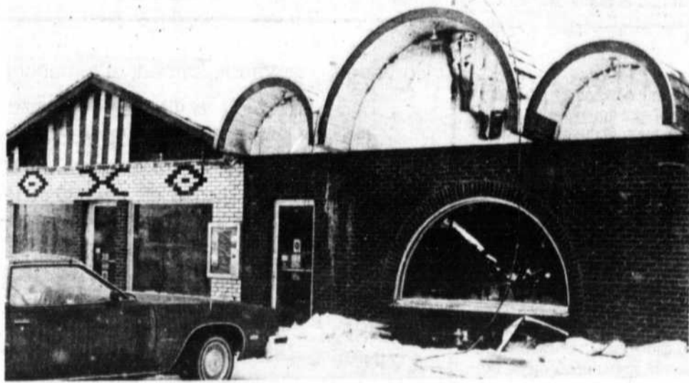
Comme on peut le remarquer, les murs de la bâtisse ont quelque peu résisté à l'élément destructeur. A l'intérieur, toutefois, tout a complètement été détruit, malgré la prompt intervention des pompiers de Mascouche.
