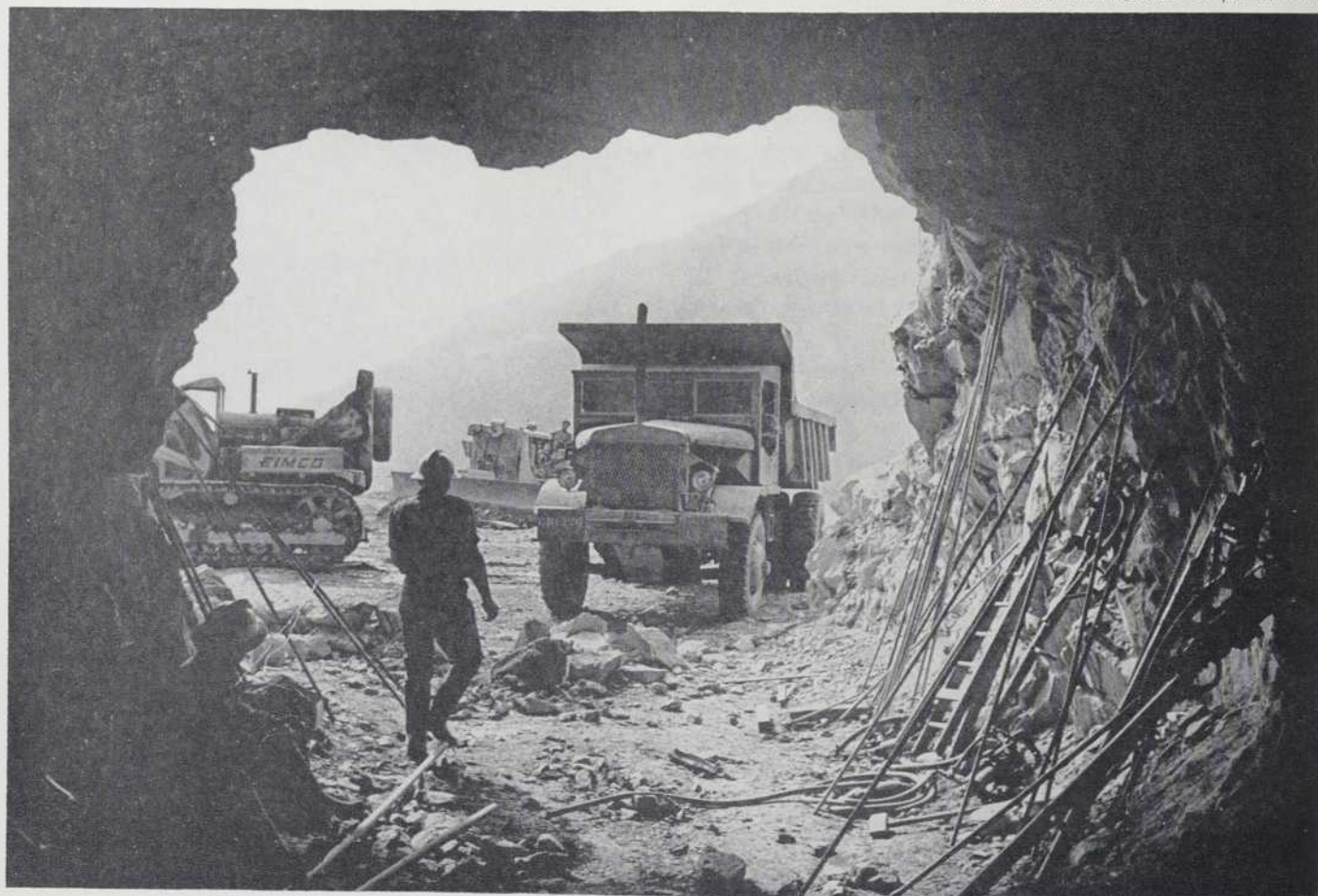
Le matériel de marinage (pelle sur chenilles et camions) avant le début de janvier 1960.
