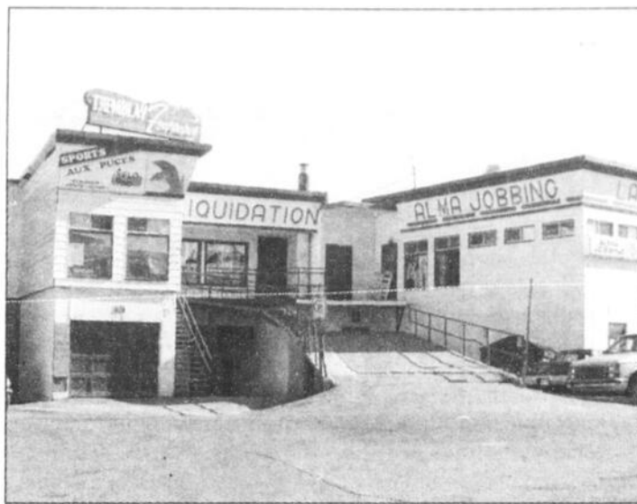
STATIONNEMENT - La SIDAC Carré centre-ville prévoit ajouter 50 aires de stationnement par l'achat et la démolition de la bâtisse abritant Alma Jobbing.
