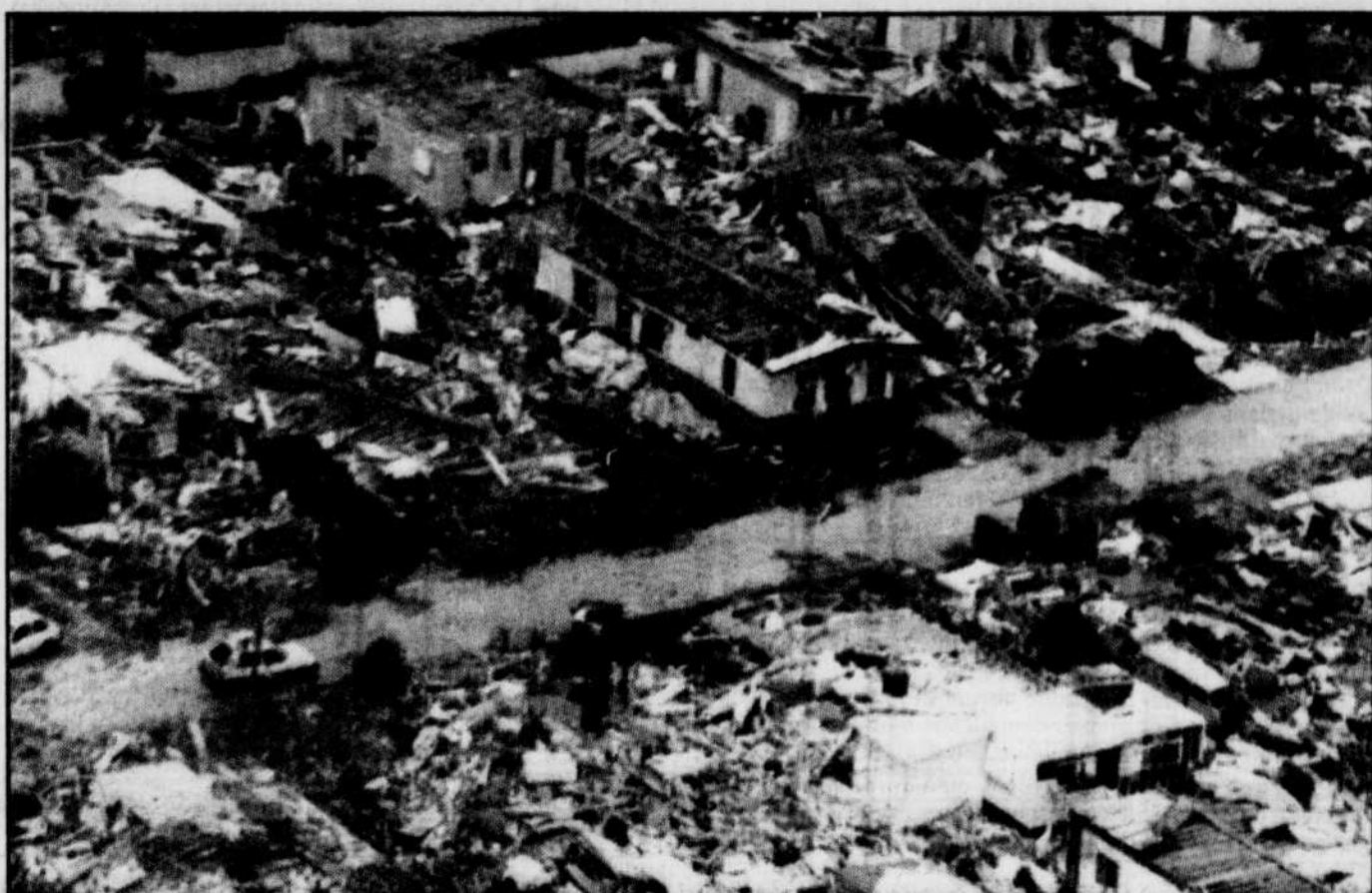
Un parc de maisons mobiles situé dans le sud-ouest du comté de Dade a été rasé par les vents atteignant 240 km/h. L'ouragan Andrew a fait huit morts en Floride et quatre autres aux Bahamas.
