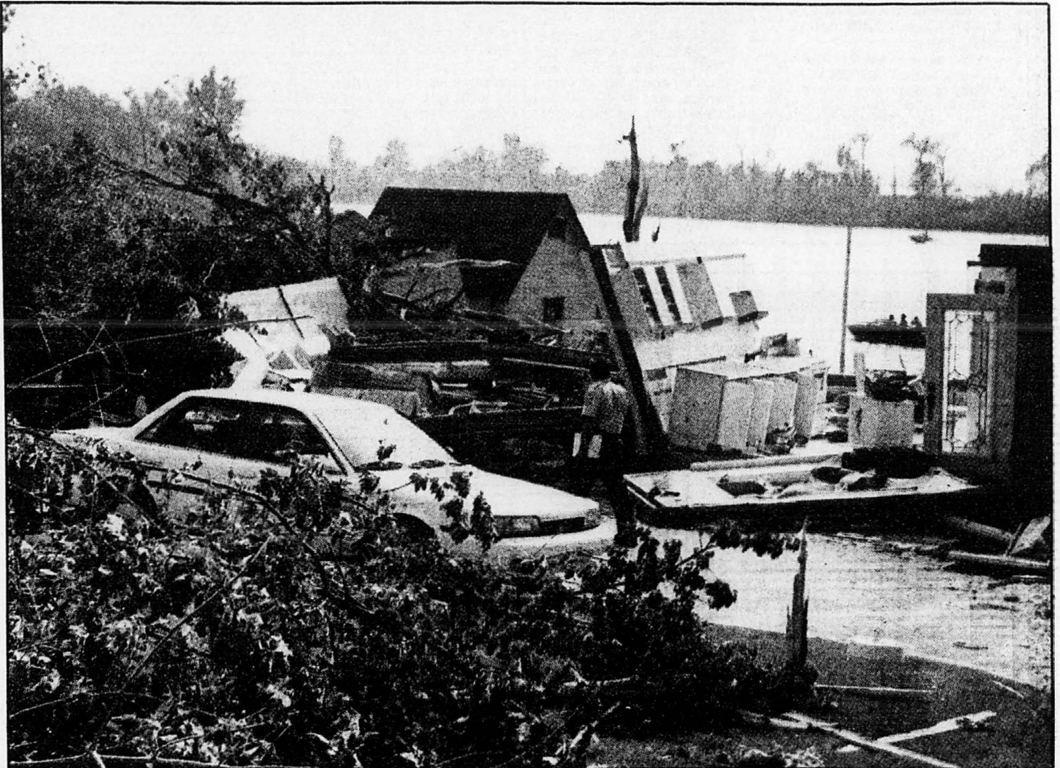
La maison des Rémy, située au 181 chemin des Patriotes, a été une des plus touchées par la tornade, hier, à Saint-Charles-sur-le-Richelieu. Sur la droite, on aperçoit la seule pièce encore debout après le passage de la tempête: la chambre où le couple avait trouvé refuge...
