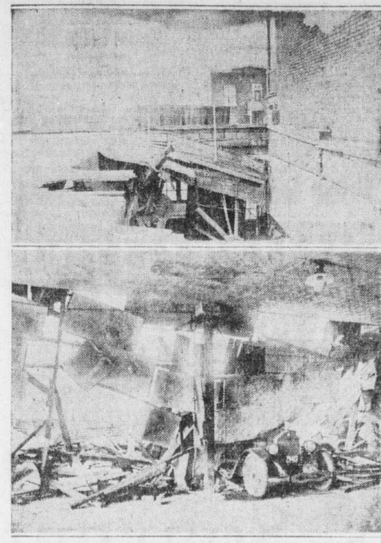
En haut le toit du garage de l'avenue Melrose, Notre-Dame-de-Grâce, enfoncé par le mur de la maison adjacente...
