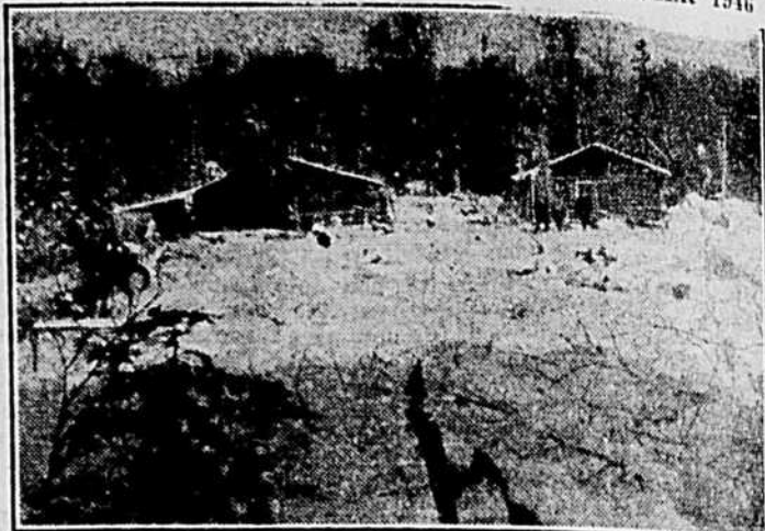
Nous sommes toujours au Chantier coopératif de Rivière-à-Pierre. Cette photo prise aux abords du camp montre l'écurie, la boutique de forge et l'atelier de menuiserie.
