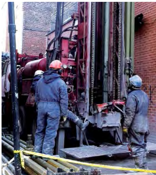
Forage de puits géothermiques
