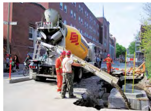
Travaux préparatoires au réaménagement de l'avenue Laurier Est
