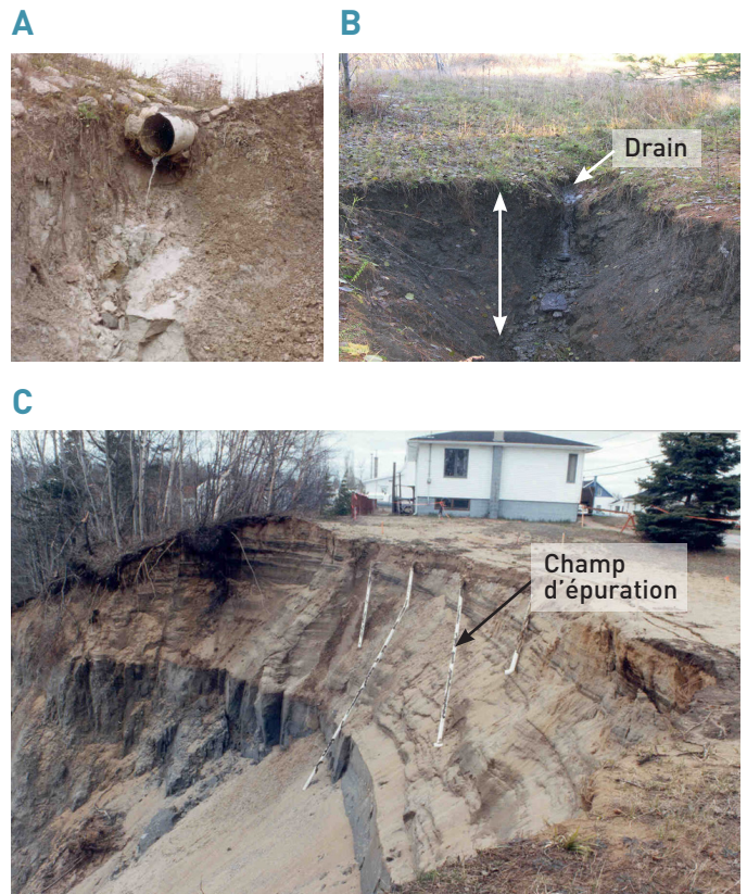
Figure 20 | Exemples d'interventions qui ont pour effet de provoquer une concentration d'eau pouvant nuire à la stabilité d'un talus : A) ravinement provoqué à la sortie d'un ponceau; B) érosion verticale provoquée à la sortie d'un drain; C) infiltration d'eau dans le sol due à un champ d'épuration
