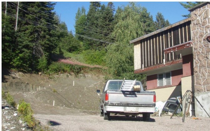
Figure 19 | Excavation réalisée pour l'entretien des fossés pouvant être néfaste à la stabilité d'un talus
