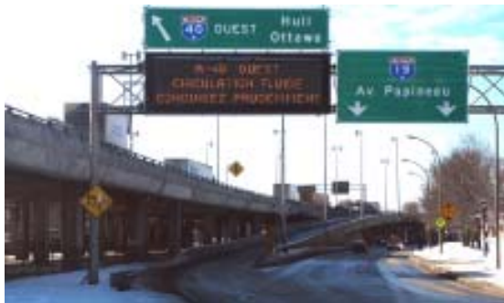
Figure 2 Panneau à messages variables de bretelle
