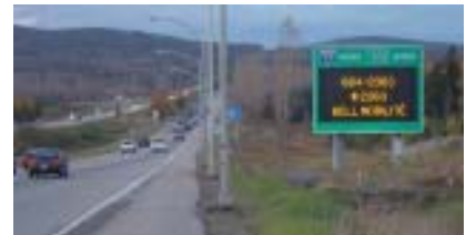
Figure 3 Panneau à messages variables latéral
