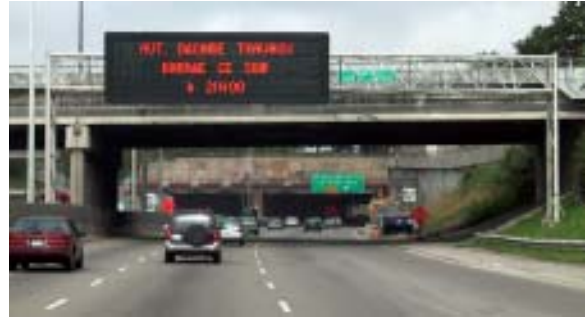
Figure 1 Panneau à messages variables d'autoroute
