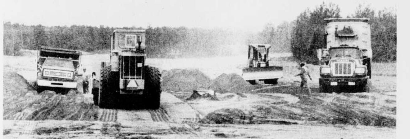
Les camions exécutent quotidiennement de 400 à 500 voyages. Cela témoigne bien de la grande activité du chantier ces temps-ci.
