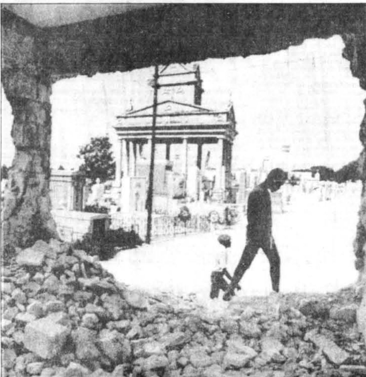
Cet amas de pierres est tout ce qui reste du mausolée qui abritait, au cimetière de Port-au-Prince, la tombe de François Duvalier.
