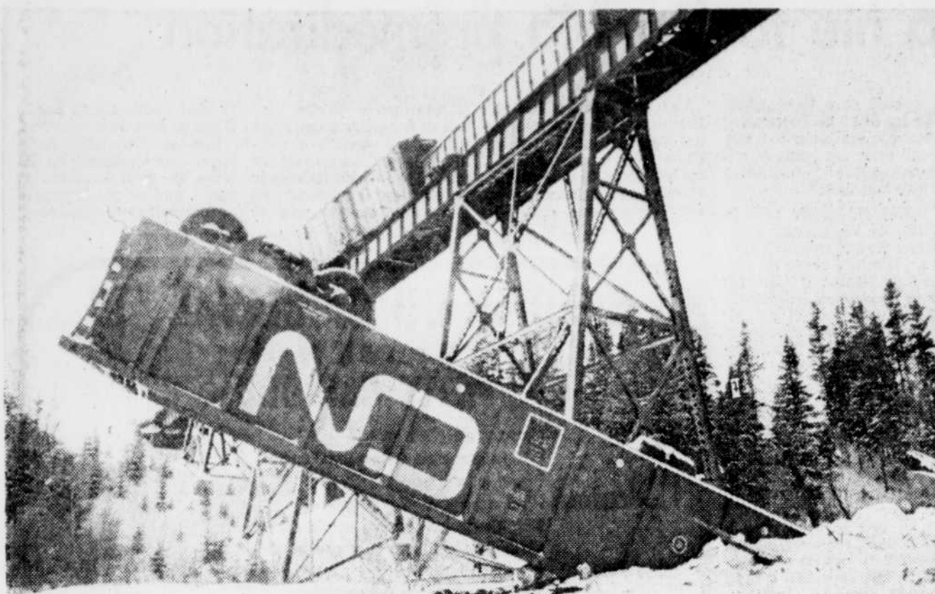
Déraillement sur le pont de la rivière de l'Anse-à-Beaufils.
