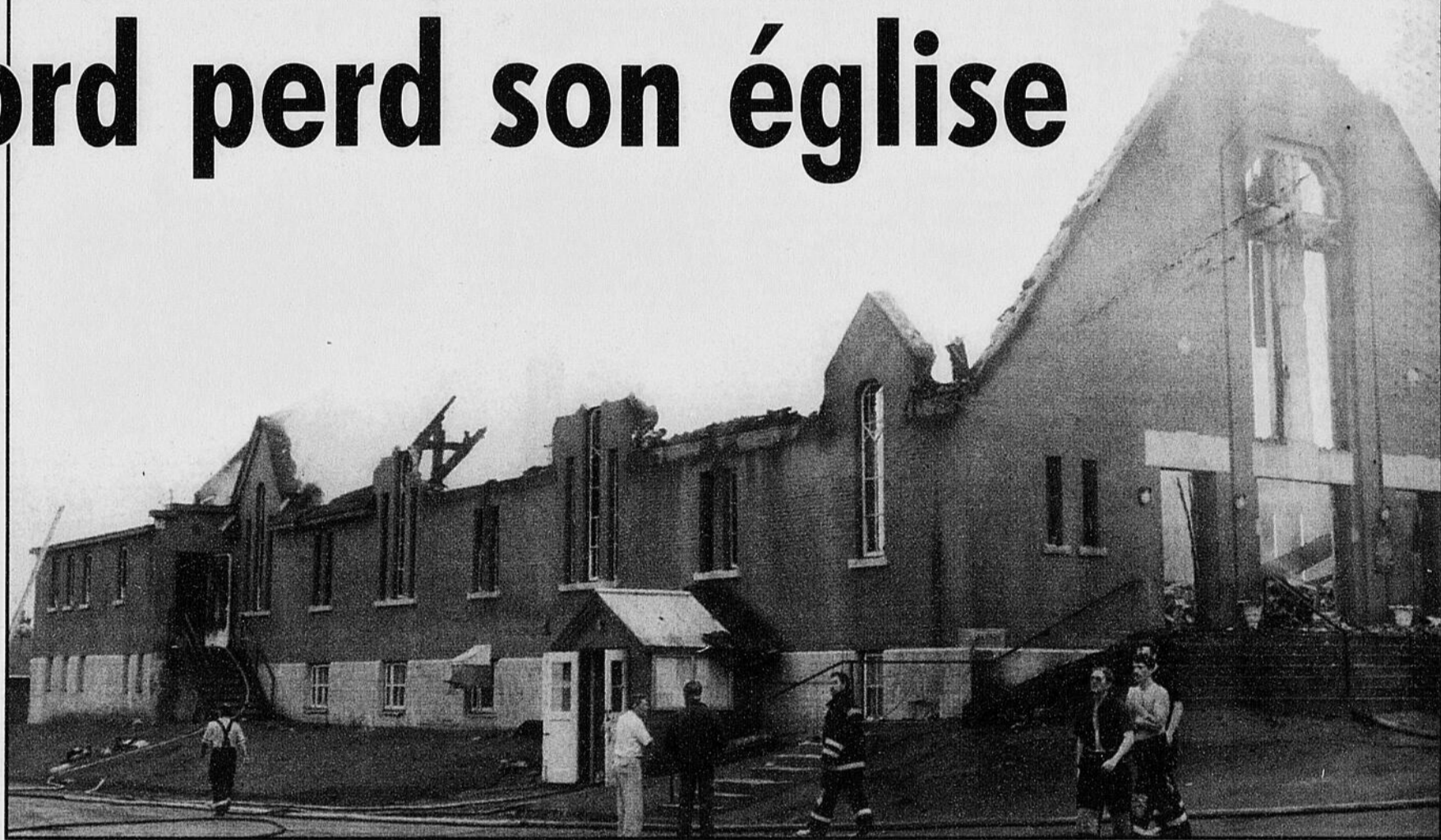
En l'espace d'un éclair, peu avant l'aube, l'église Saint-Gabriel de Stratford a été ravagée par les flammes. Seuls les murs ont résisté mais à cause de leur état précaire, ils devront être démolis. Le sinistre serait imputable à une défectuosité électrique.
