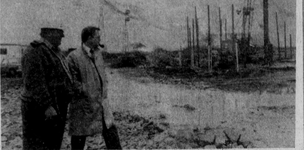
En compagnie du responsable des travaux, le maire Mooijekind examine le chantier de l'usine Alby. (Photo Le Soleil Jacques Smith)
