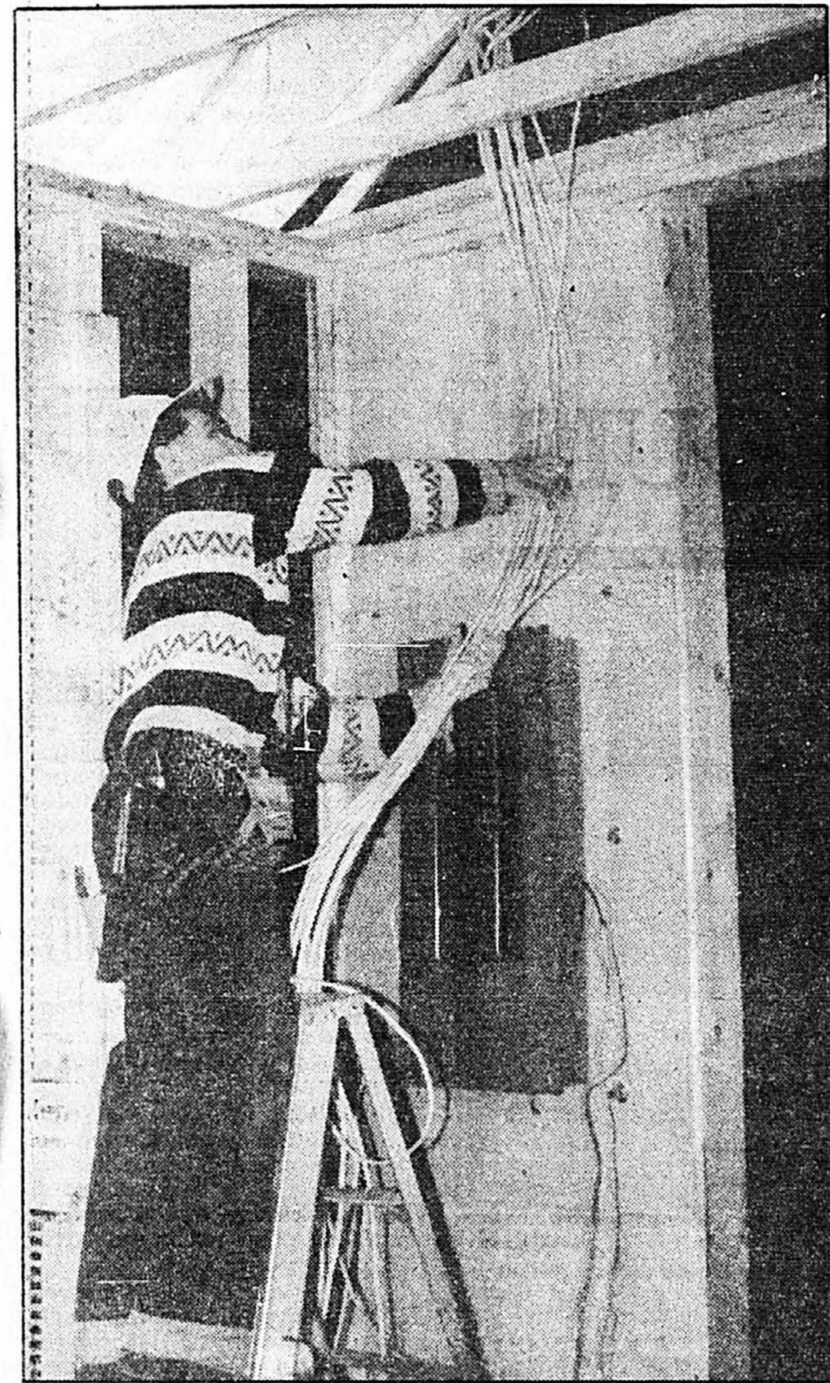
Serge Boyer tire son «spaghetti» vers le panneau de distribution. Il goûtera bientôt les joies du «démêlage».
