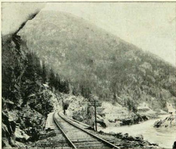
Gorge du Fraser.—Tunnels au-dessus de Spuzzum.
