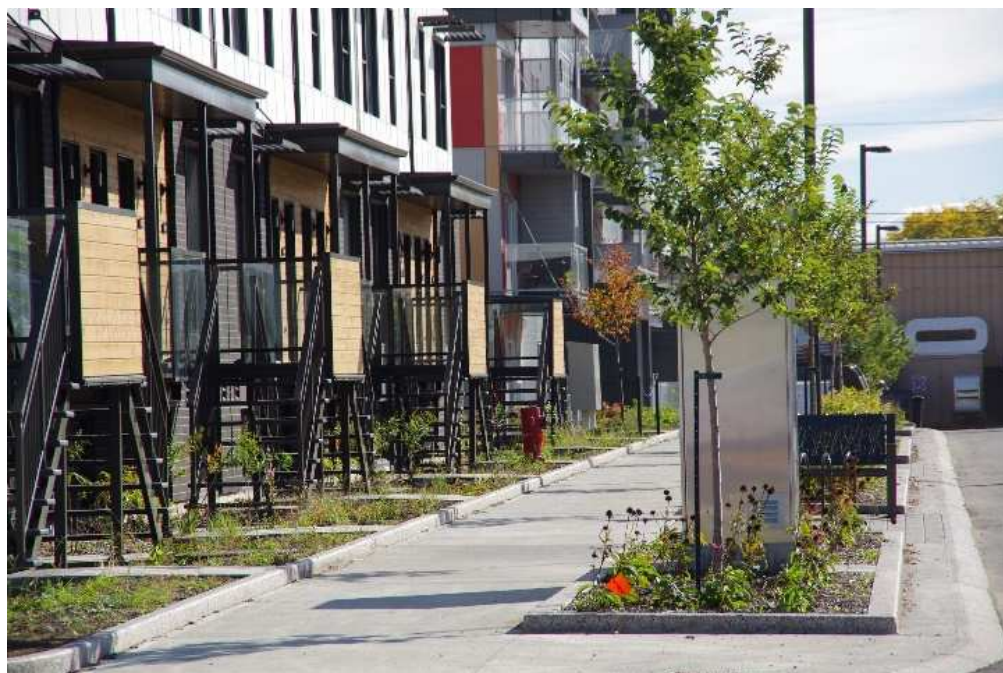
Figure 19 | Une banquette avec emprise électrique.
