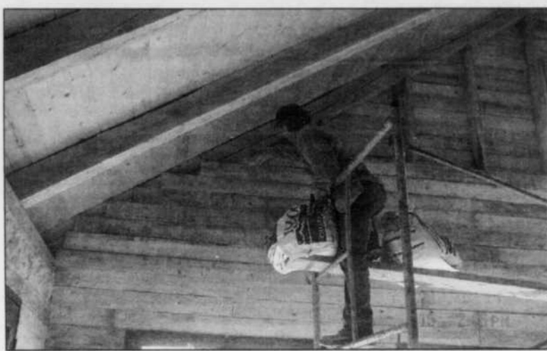
LAINES DE MOUTON - Matière 100 % naturelle, la laine de mouton offre des performances techniques étonnantes ainsi qu'une régulation hygrométrique exceptionnelle. Michel Bouchard travaille sur le développement de cet isolant naturel depuis une dizaine d'années.
