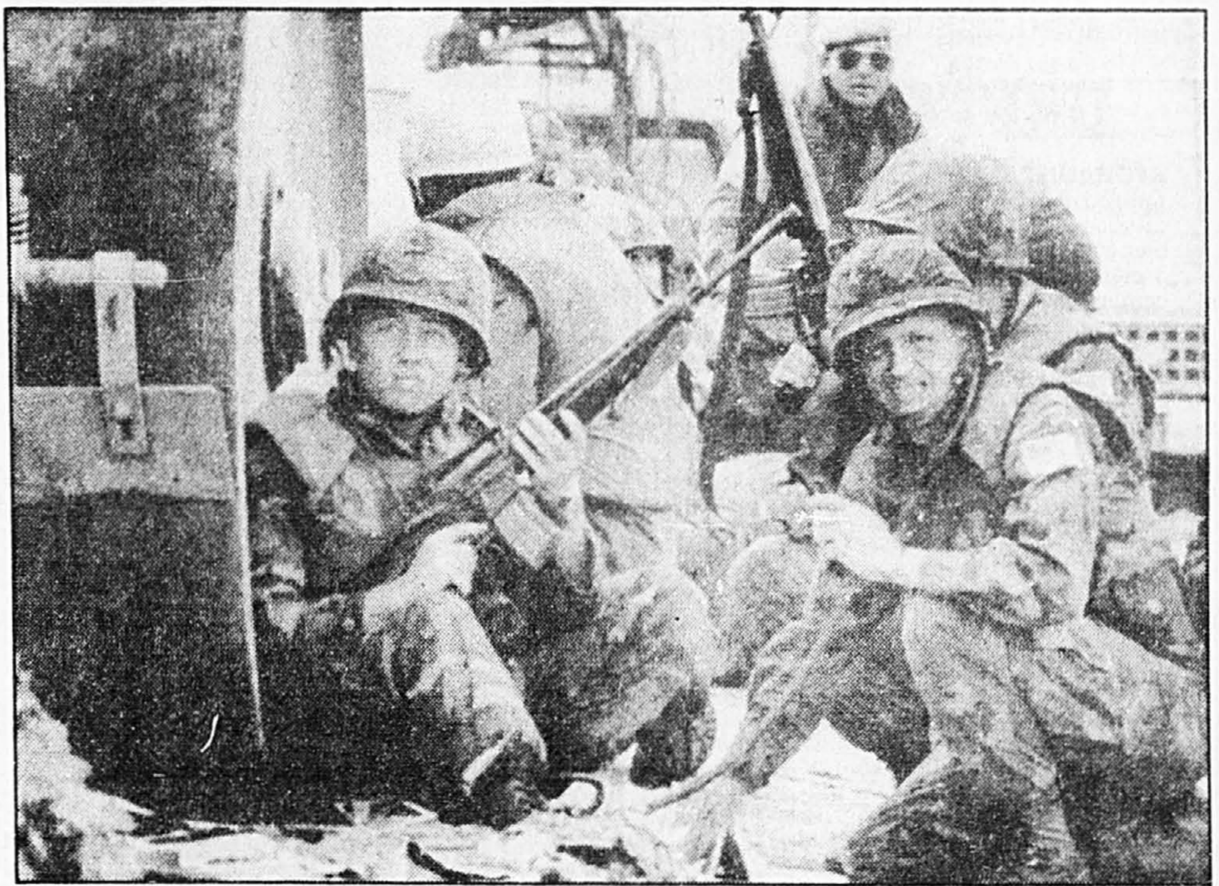
Des fusilliers marins américains s'abritent derrière un rouleau à vapeur après qu'une grenade eut été lancée sur une patrouille près de Beyrouth.
