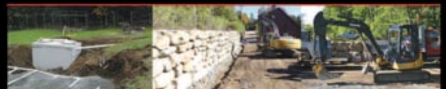
INSTALLATION DE FOSSE SEPTIQUE
