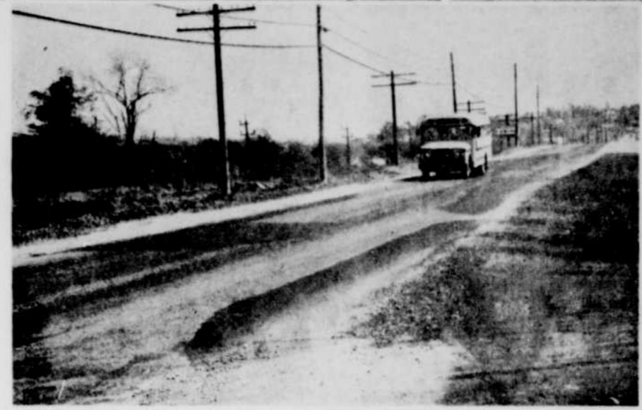
ROUTE SEMI-NEUVE. — Des travaux d'asphaltage ont été effectués sur la route 5, entre Sherbrooke et Bromptonville. La route est demeurée un peu cahoteuse, mais les trous sont disparus.
