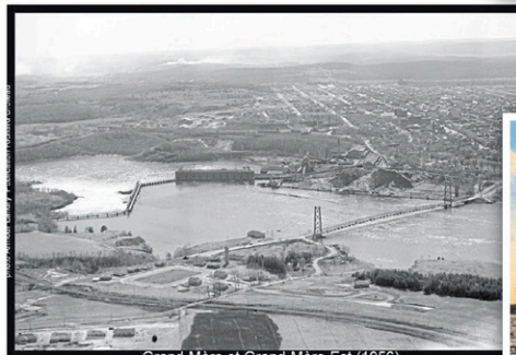
Usine Laurentide de Grand-Mère, aérien
