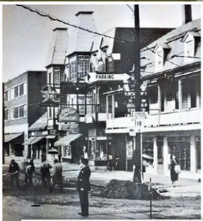
Vers 1940, Travaux coin 6 e et 7 e
