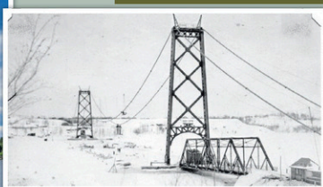
Pont de Grand-Mère, construction
