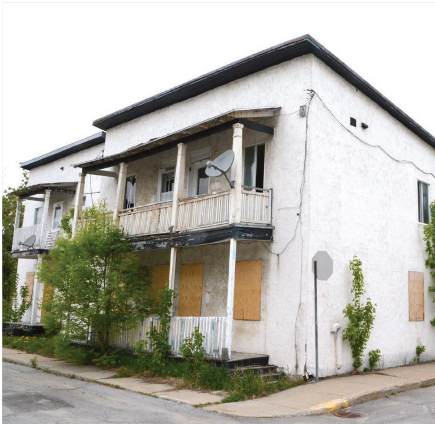
Ces bâtiments désaffectés, qui se trouvent à l'emplacement du futur édifice de l'OMHTR, devront être démolis. Cette opération sera plus difficile que prévu, car on y a découvert de l'amiante. PHOTO GUILLAUME JACOB
