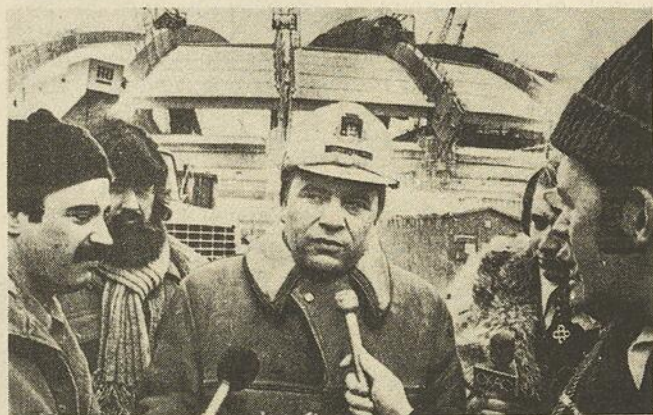
Me Cyrille Delage, sur les lieux de l'accident au chantier olympique, a été nommé par le ministère de la justice pour enquêter sur la mort de quatre ouvriers plus tôt cette semaine.
